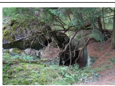
Bunker (links der zerstörte Teil)
